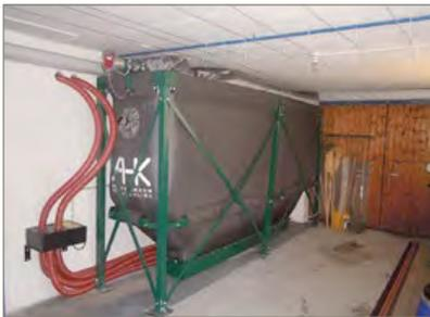
Abb. 10b: Trog silo mit mehreren Saugentnahmepunkten
